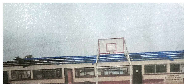
Finalizacion de pintura de costaneras.
