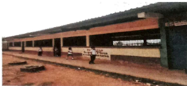
Culminacion de entechado.
