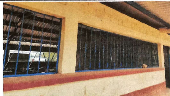
Culminacion de instalacion de balcones.
